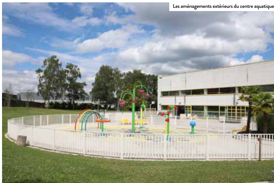
Les aménagements extérieurs du centre aquatique.
