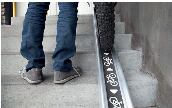
Figure 17: Goulotte pour les cyclistes qui veulent rejoindre la promenade haute
