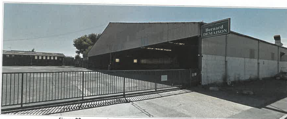
Figure 23 : Aspects extérieurs : Bardage tôle et murs parpaings
