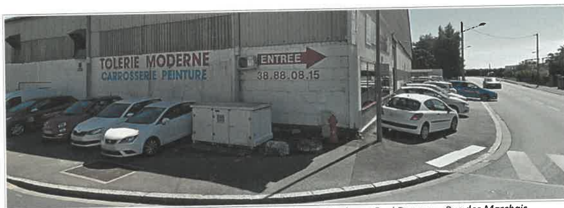
Figure 16 : Position du transformateur électrique – Angle rue Paul Doumer – Rue des Marchais
