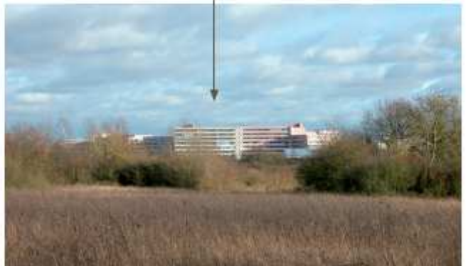
immeubles d'habitations des Chaises
